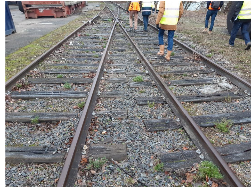
Figure 17 : Voies ferrées au niveau du terminal sud
