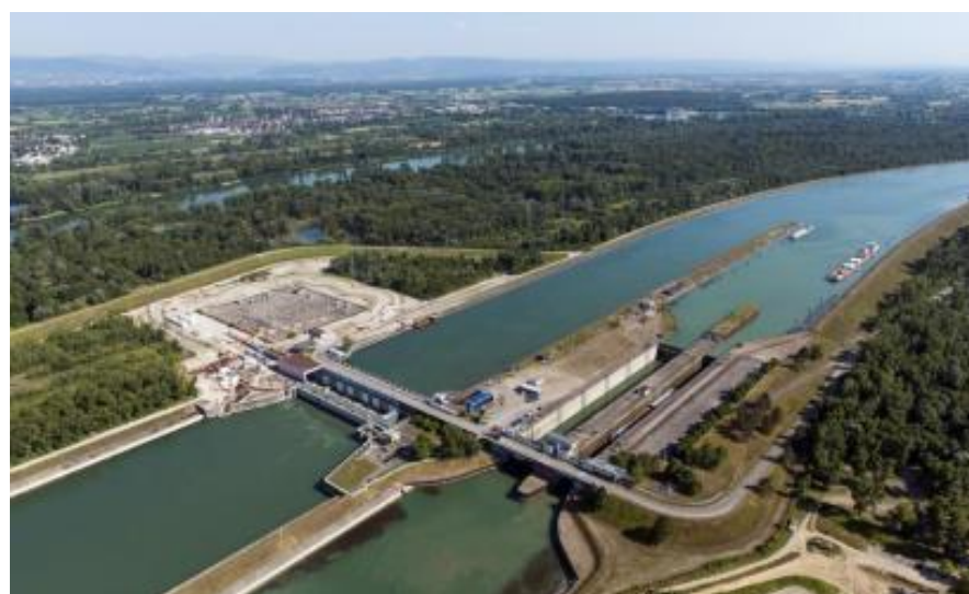
Figure 48 : Vue aérienne de l'écluse EDF et de la centrale hydroélectrique
