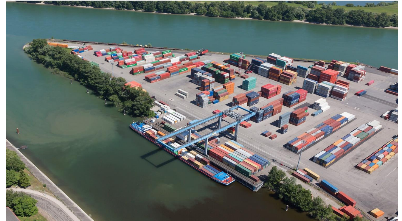
Figure 46 : Vue aérienne de la berge de Terminal Conteneur Sud avec portique (source : site internet du Port autonome de Strasbourg)
