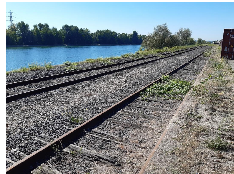
Figure 18 : Voies ferrées au niveau du terminal sud
