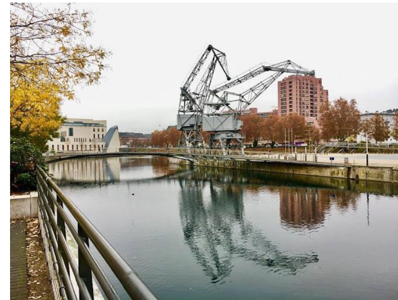
Figure 52 : Anciennes grues, bassin d'Austerlitz
