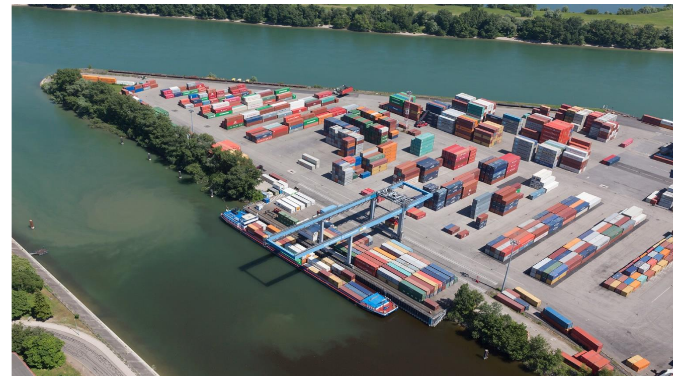
Figure 8 : Vue aérienne de la berge de Terminal Conteneur Sud avec portique (source : site internet du Port autonome de Strasbourg)
