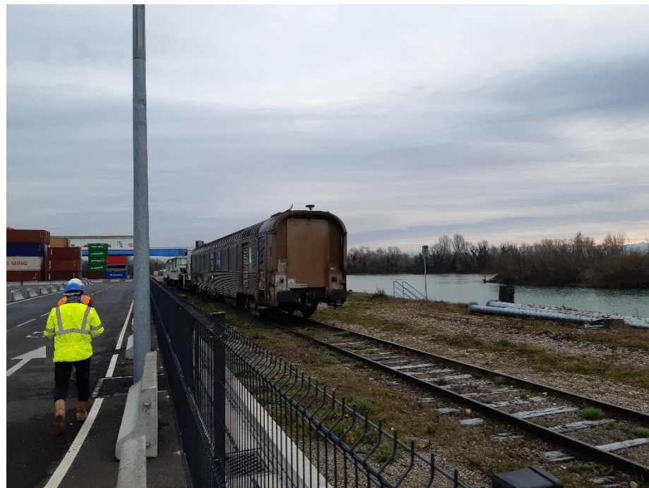
Figure 16 : Voies ferrées au niveau du terminal sud
