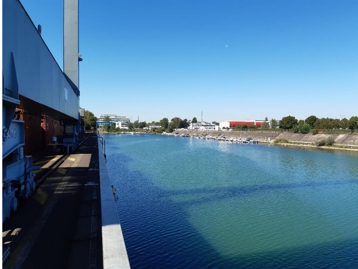
Figure 29 : Vue vers le bassin Gaston Haelling depuis le terminal sud
