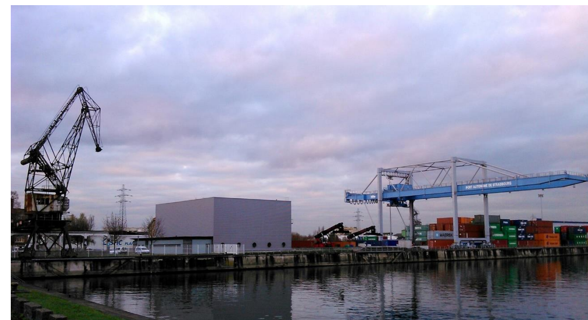
Figure 53 : Ancienne grue (à gauche) et nouveau portique (à droite), bassin du Commerce
