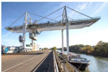
Portique sur rail (Energie électrique)
